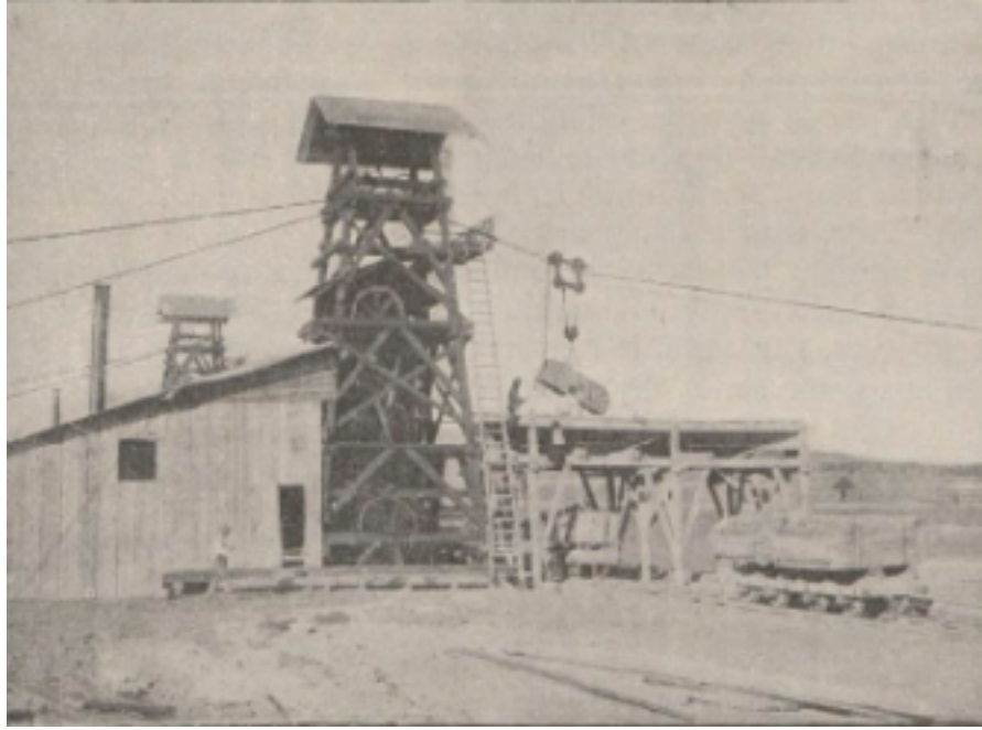
FIG. 35. — Transporteur aérien pour l'excavation de l'une des formes de radoub de Sidi-Abdallah (pylône moteur).
