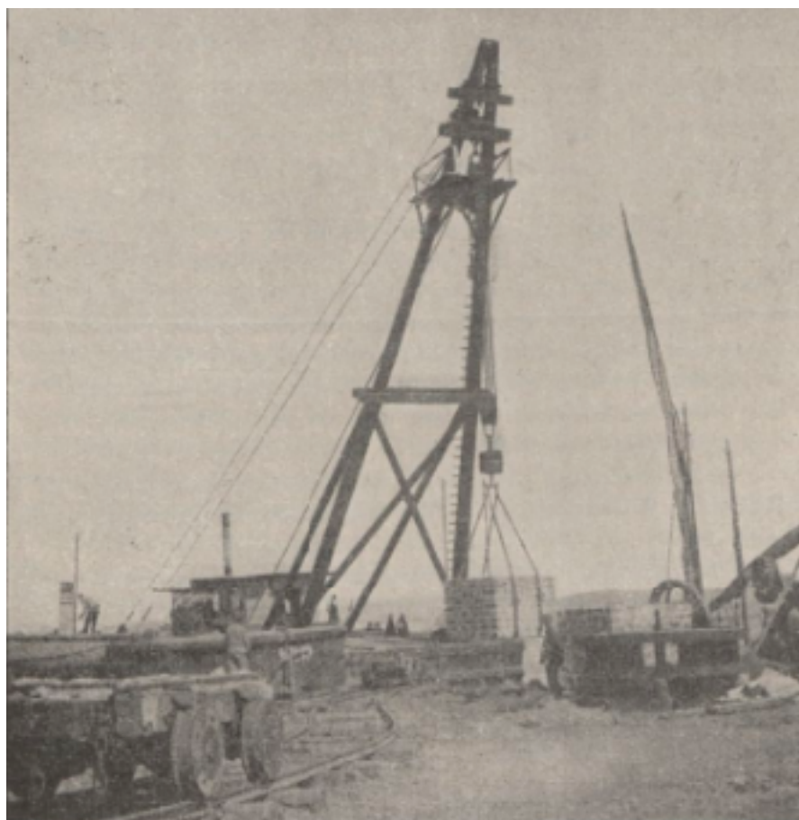
FIG. 34. — Machine à mâter de 50 tonnes.
