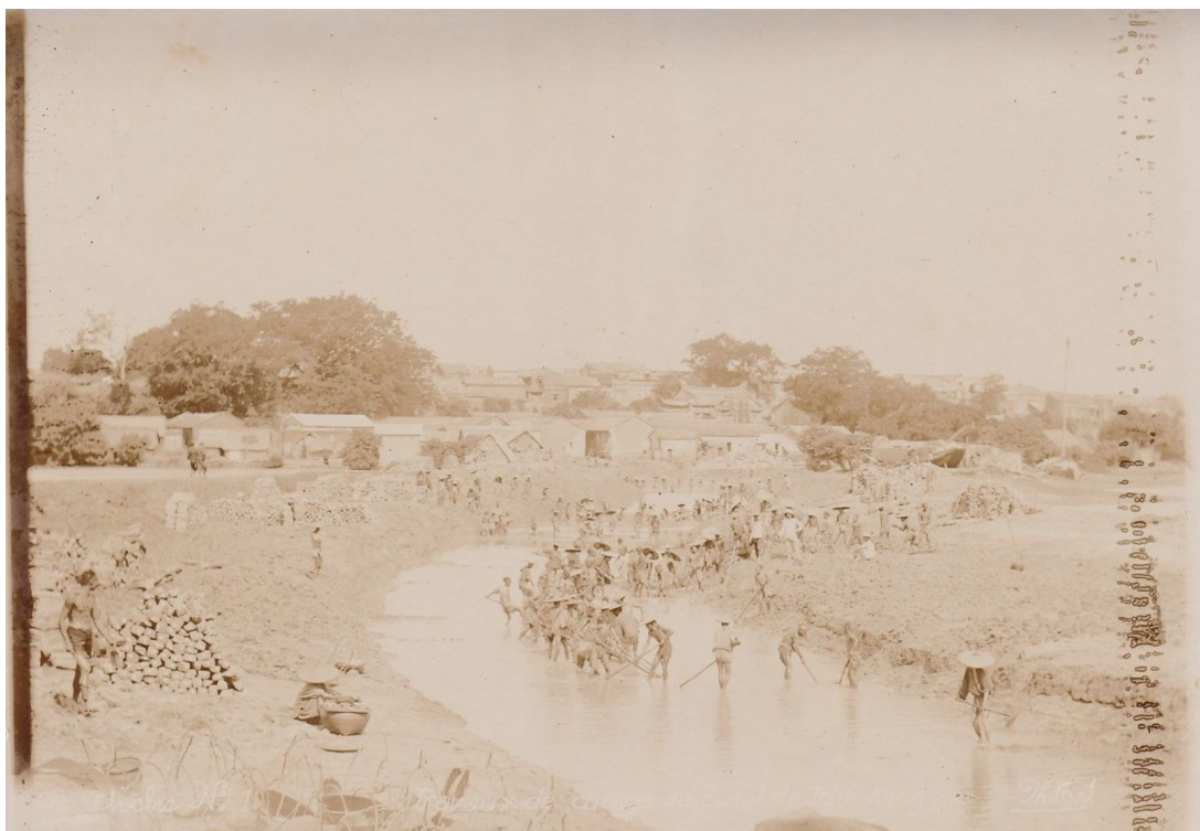
N° 1 Travaux de curage du canal de Tché-Kang
