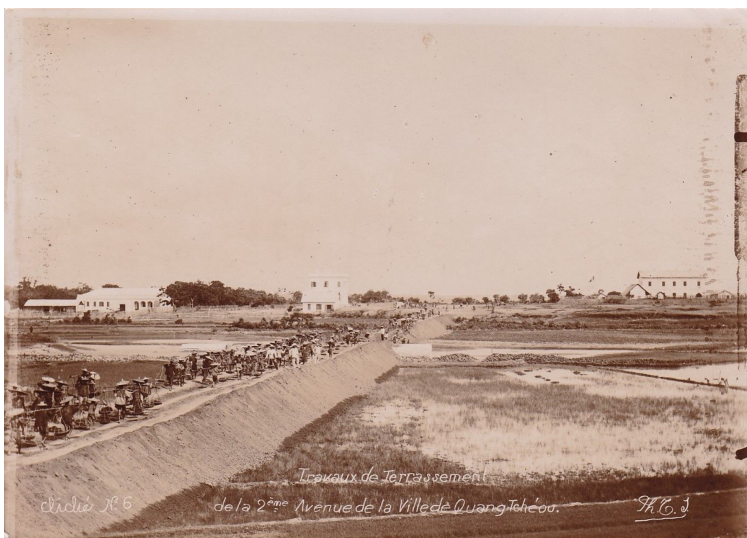
N° 6 Travaux de terrassement de la deuxième avenue de la ville de Quang-Tchéou
