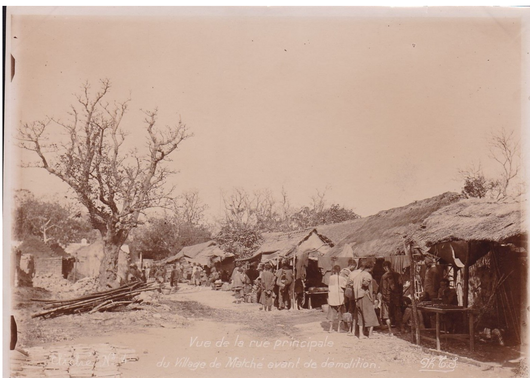
N° 4 Vue de la rue principale du village de Matché avant sa démolition
