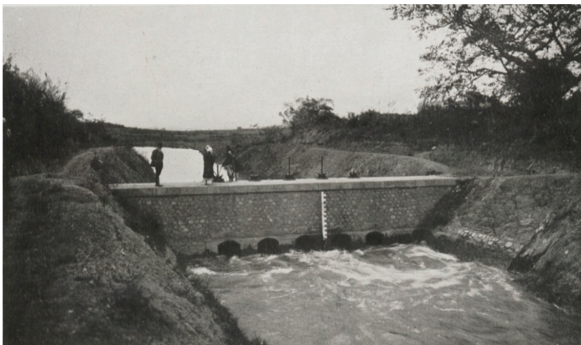
Irrigation de Kep. — Prise d'eau du-canal principal à Quang-Hiên.
