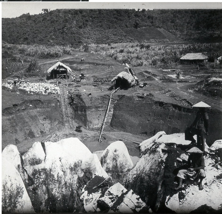
Trang-Da. — Excavation flanc Nord (2) (septembre 1915) (Fonds Henri Chabot ).
