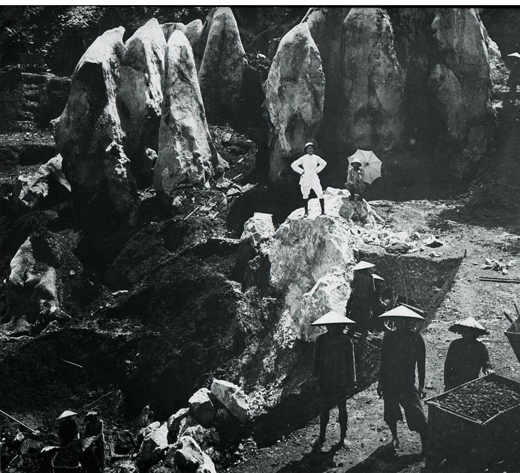
Trang-Da. — Excavation flanc Nord (1) (septembre 1915) (Fonds Henri Chabot ).
